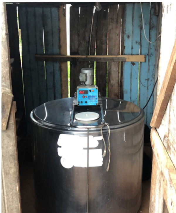
↑ Figura 2. Sala de refrigeração inadequada. Fonte: Karine Zambam (2022).
