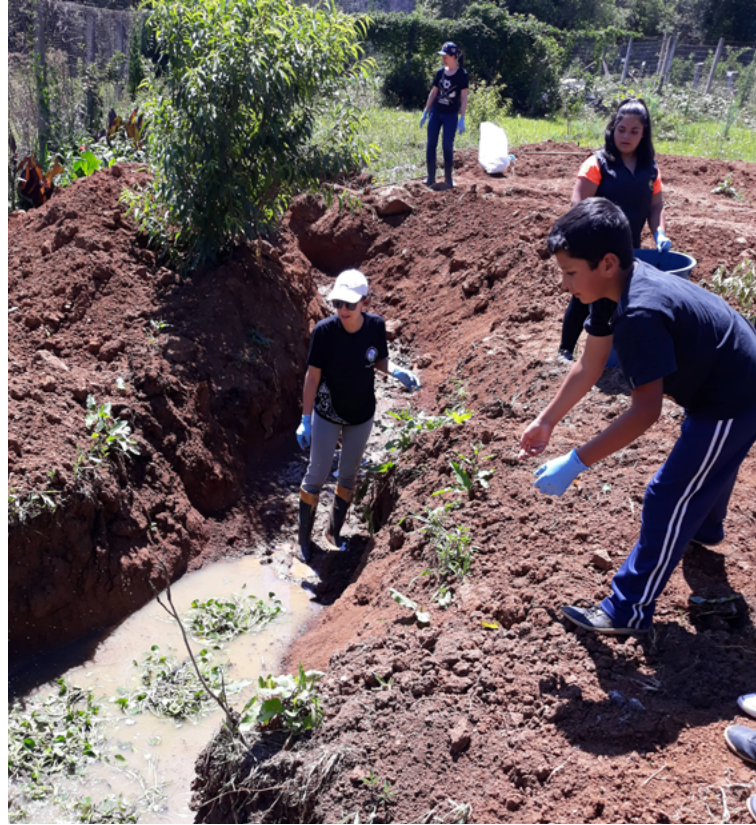
↑ Figura 4. Implantação da macrófita aguapé ( Eichhornia crassipes ) no “córrego” com o efluente da Escola Municipal João Becker da Silva. Fonte: Simone Piton Lancini.
