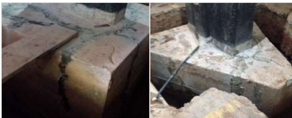
Figura 11: Tratamento de injeção de resina nos blocos de fundação.
