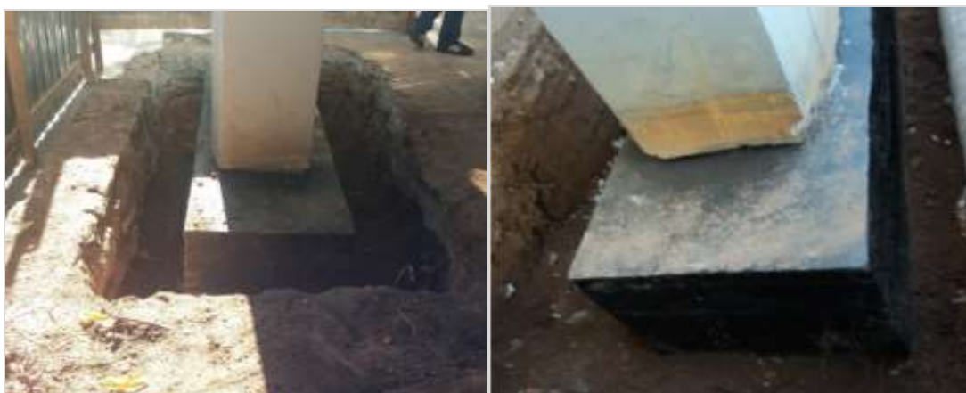
Figura 12: Bloco de fundação após impermeabilização.
