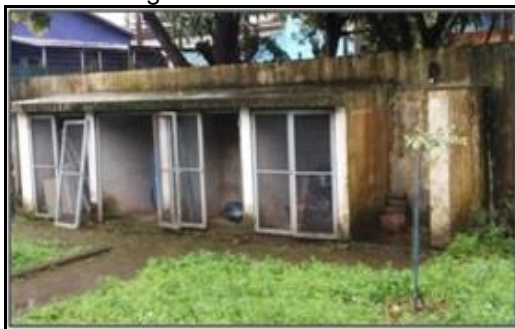
Figura 20 - Portas do abrigo externo da unidade com a tela de proteção
