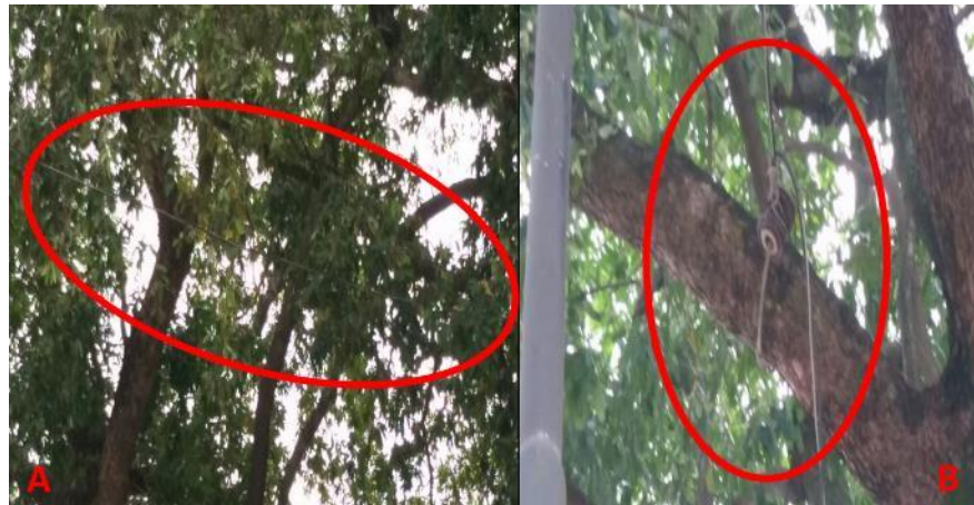
Figura 4: A-B - Árvores de L. tomentosa em conflito com cabeamento elétrico próximo à Praça Barão do Rio Branco.
