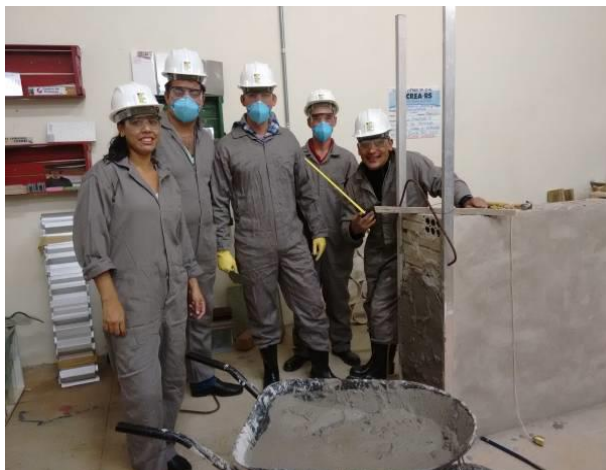
Figura 6: Alunos desenvolvendo as etapas de revestimentos argamassados. Fonte: Autores
