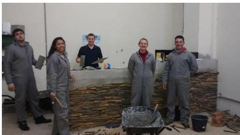
Figura 8: Revestimentos em pedra em andamento. Fonte: Autores
