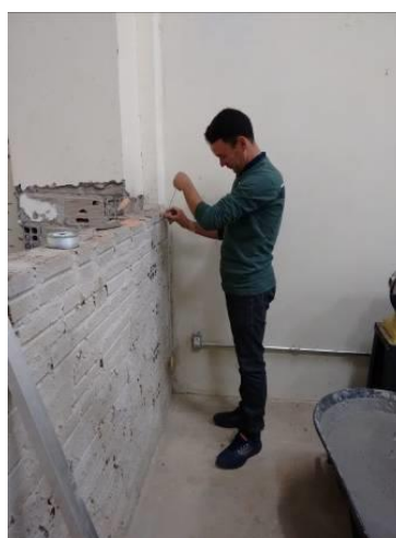
Figura 5: Conferências com prumo de face. Etapa em andamento dos revestimentos argamassados.
