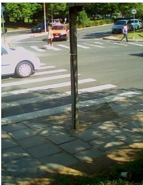
**Figura 6.** Detalhe da rampa próxima à faixa de pedestres, com a presença de obstáculo.
