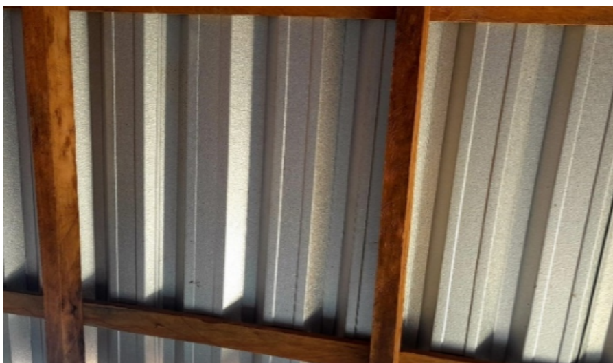
Figura 2 – Fotografia do telhado construído
