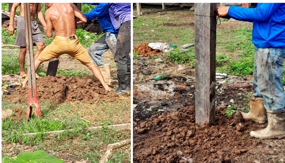
Figura 1 – Fotografias da fixação de um esteio sendo erguido
