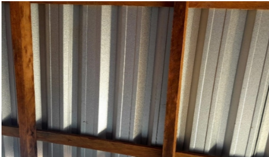
Figura 2 – Fotografia do telhado construído
